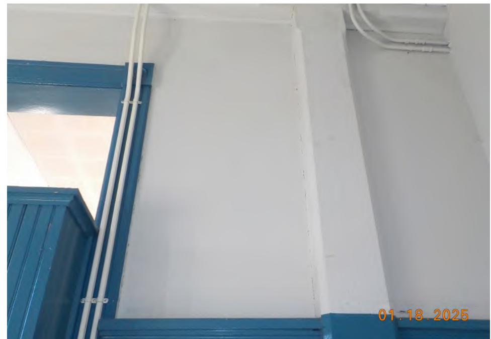
022A Wall C
