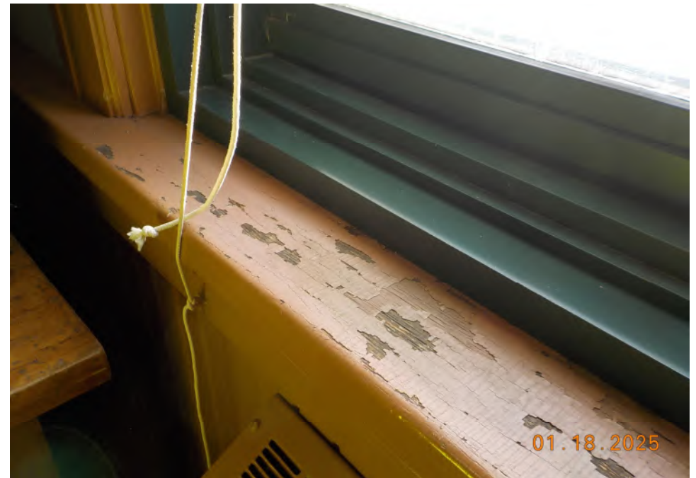
026A Windows sill
